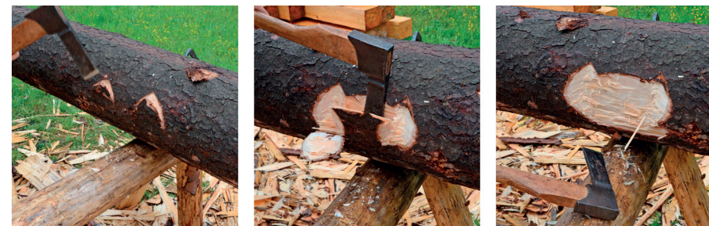
Obr. 5.2.8: Výroba lísky pro založení kulatiny na kozách
