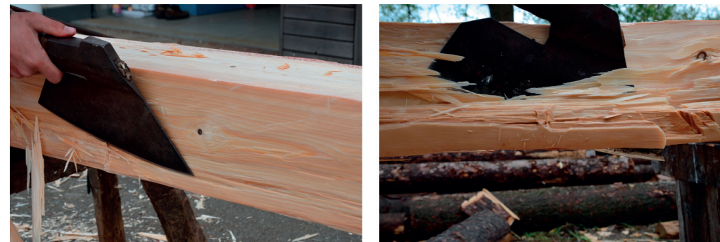
Obr. 5.3.24: Při nepříznivé točitosti má tesař nakloněnou sekeru na špičce, prosekává hranu a couvá
