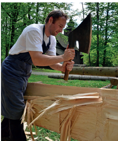
Obr. 5.4.23 Lícování vnitřní plochy půlkulaté srubnice
