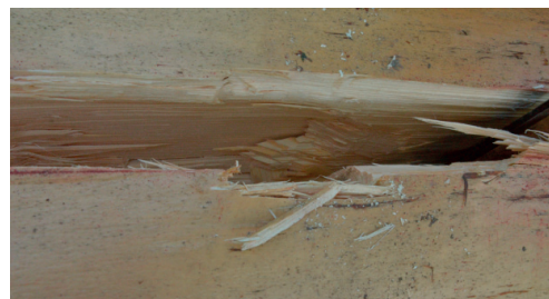
Obr. 5.4.12 Přetnutá vlákna v místě štěpné spáry
