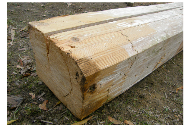
Obr. 3.14: Přetržení vláken na tahové straně obýbaného trámu způsobené odlupčivou trhlinou
