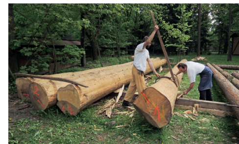
Obr. 5.4.1 Navalování a kotvení kulatiny na podvalech
