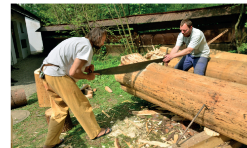
Obr. 5.4.2 Krácení na požadovanou délku prvku
