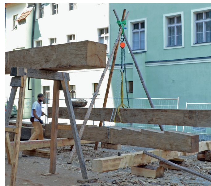
Obr. 5.1.11: Trojnožka s kladkostrojem
