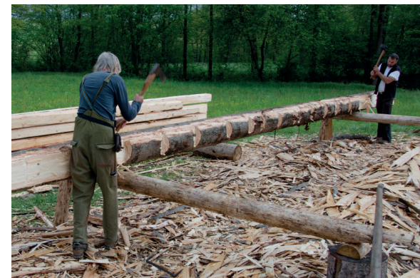
Obr. 5.3.16: Párové hrubování, kdy tesaři jdou na stejné straně kulatiny proti sobě
