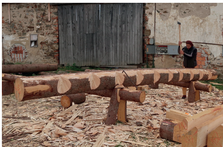
Obr. 5.2.7: Usazení kulatiny kobyloú navrch
