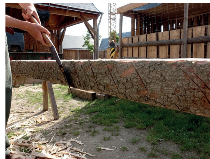
Obr. 5.3.12: Vrubování šířčinou při malé hloubce vrubu
